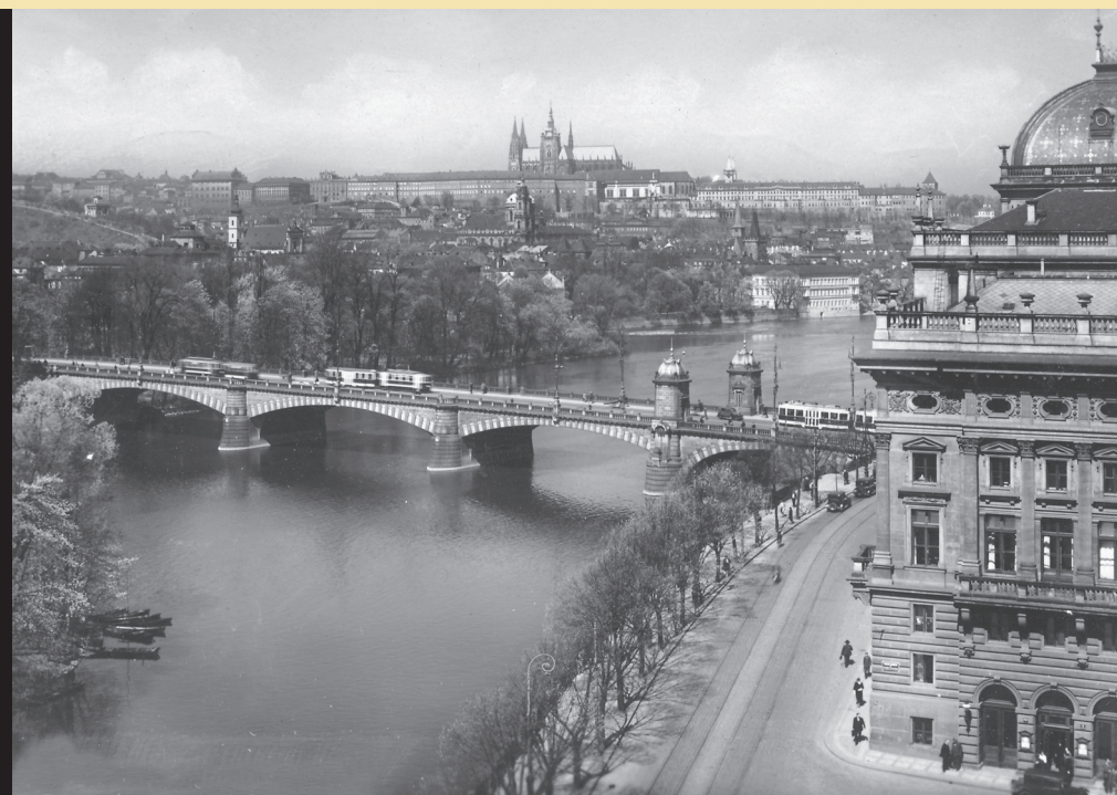
Dobová pohlednice mostu Legií
